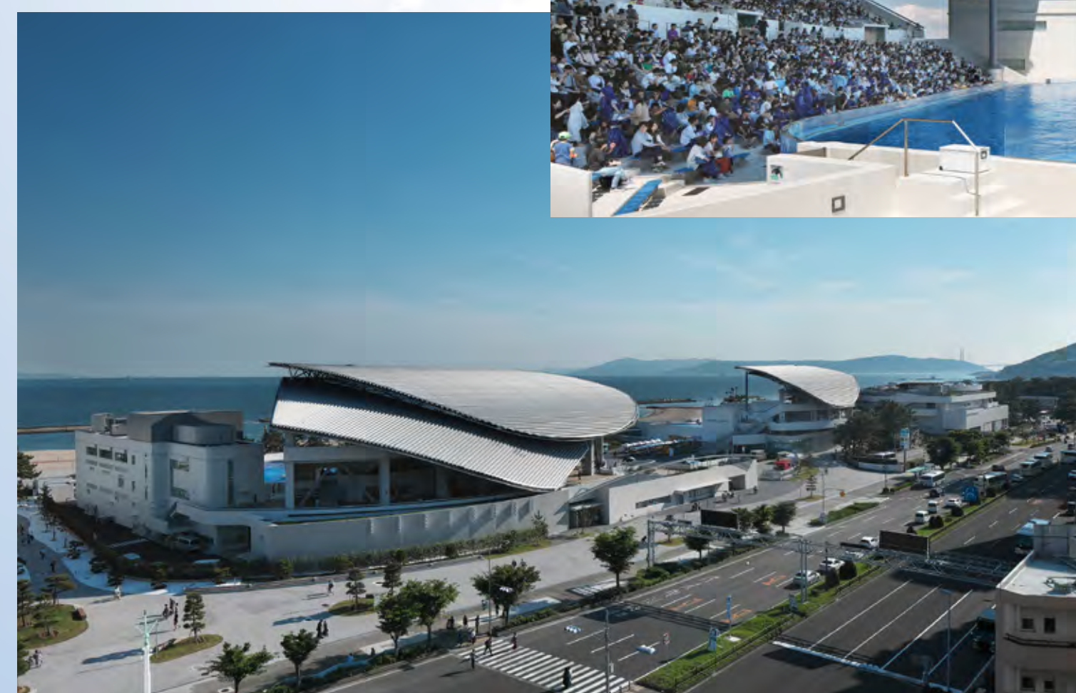
神戸須磨シーワールドの設計と施工
