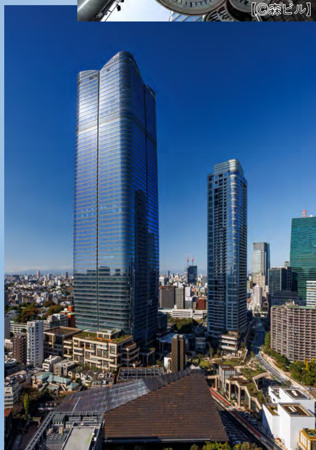
麻布台ヒルズ森JPタワーの設計と施工 【©川澄・小林研二写真事務所 浜田昌樹】
